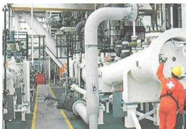
Системы приёма и запуска очистительных снарядов и диагностических устройств
